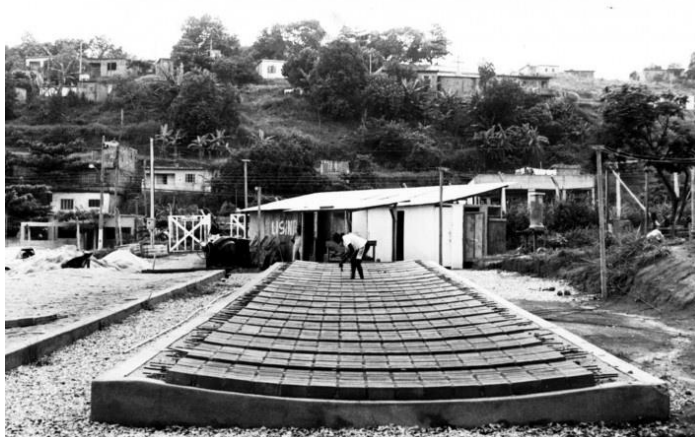
Figura 04 – Painéis de bloco cerâmico para moradias da UNICAMP.
