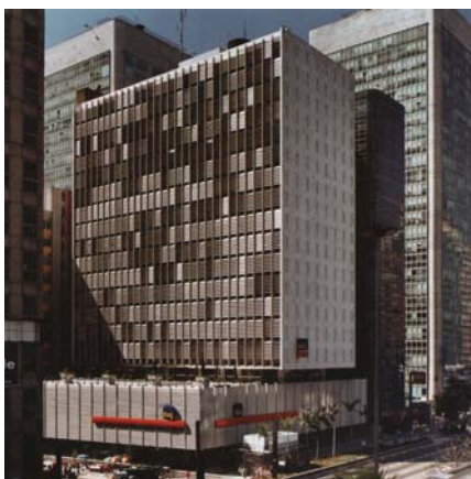
Fig. 07 – Uso de brises horizontais em edificação na Av. Paulista. Banco Sul Americano S.A., São Paulo, Brasil, projeto de Rino Levi, construído em 1.960/1.963.
