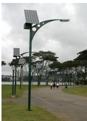
Figura 13: Painéis solares em postes de luz.
