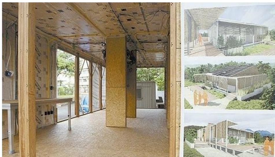
Figura 2 - Na imagem podemos compreender a utilização dos painéis OSB na montagem da casa e a facilidade na acoplagem de encanamentos e fiações. Fonte: http://www.bancodaarvore.com.br/ , 2012, acesso em: 02/09/2015.
