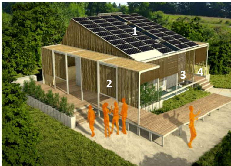
Figura 3 - A Ekó House – Na imagem, os painéis fotovoltaicos (1), a utilização da madeira como revestimento e estrutura (2), os brises na varanda (3) e as plantas macrófitas (4). Fonte: ekobrasil.org, 2012, acesso em: 02/09/2015.
