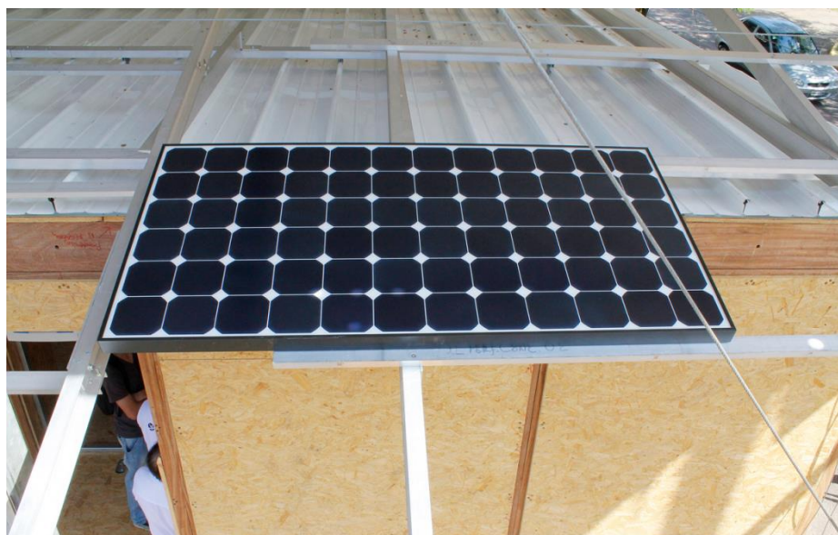
Figura 4 - Painéis Fotovoltaicos sendo instalados durante a construção da Ekó House Fonte: http://www.imagens.usp.br/?p=14388 , 2012, acesso em: 02/09/2015.
