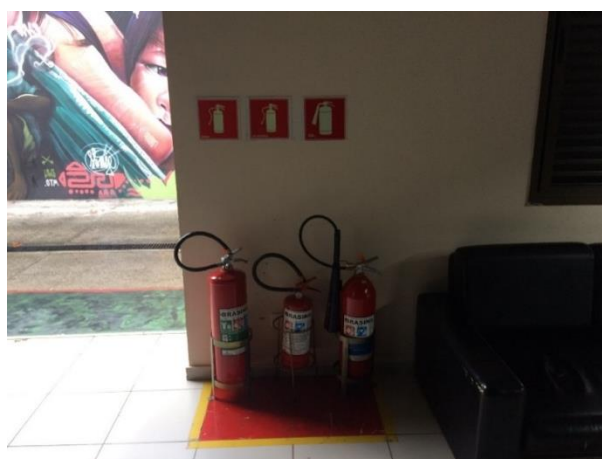
Figura 07: Extintores portáteis de acordo com a NBR 12693 e IT 21/2018 e sinalização de emergência está em desacordo com a NBR 13434 e IT 20/2018.
