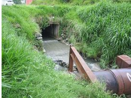
Figura 58: Córrego canalizado em sistema de galeria no subterrâneo do CEU Butantã.
