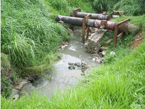
Figura 57: Tubulação de esgoto aparente.
