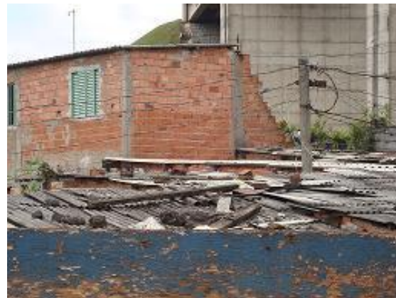
Figura 22: Método adotado pelos moradores para fixar as telhas leves.
