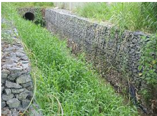
Figura 37: Canalização de parte do leito do córrego.
