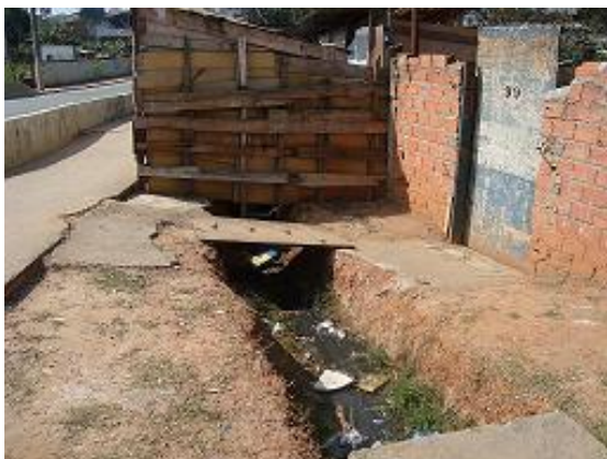
Figura 27: Captação de águas pluviais transformada em esgoto.
