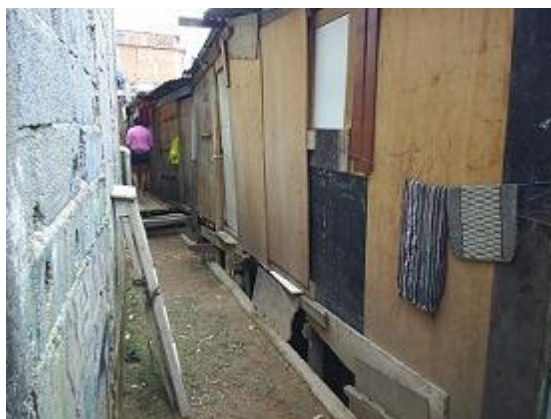
Figura 50: As estruturas de retenção/proteção das casas de alvenaria formam os passeios para acesso das moradias suspensas sobre a superfície do rio.
